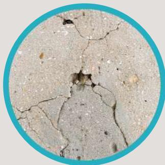
1. Calçadas: Rachaduras nas calçadas podem permitir a infiltração de água para camadas mais profundas do solo, resultando em desperdício de água e danos ao solo.
