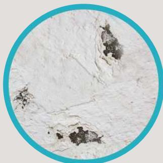
2. Paredes: Infraestruturas mal conservadas podem permitir a entrada de água nas paredes, levando a problemas estruturais e propiciando o desenvolvimento de mofo e bolor.
